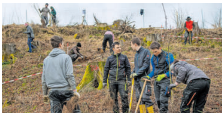
Bepflanzung des Rückhaltebeckens in Berndorf mit heimischen Wildstrüchern.
